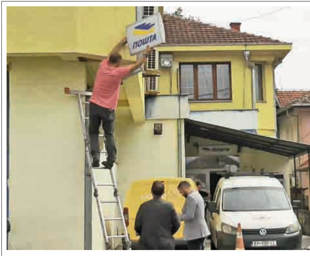
Posta e Kosovës në nëntor të vitit 2025 ka marrë kontrollin e objekteve në Graçanicë dhe Shtërpçë, ku operonte Posta e Serbisë. Posta e Kosovës ka njoftuar se pas finalizimit të procedurave ligjore, këto prona, që ishin shfrytëzuar nga një operator ilegal, janë regjistruar si pronë e ligjshme e Postës së Kosovës. Ky objekt u mbyll në kuadër të një aksioni të gjerë për shuarjen e institucioneve në jug të Ibrit, që funksiononin sipas sistemit të Serbisë
